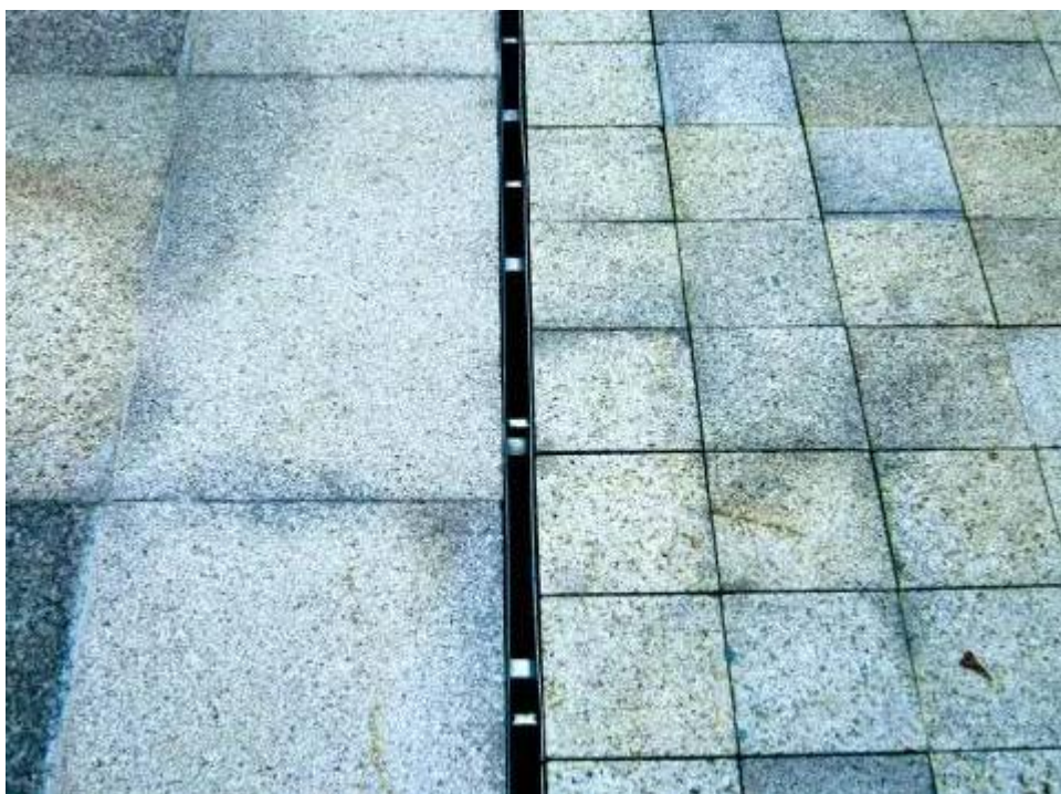
不锈钢槽排水沟，宽度完全满足排水需要，切缝工艺细致，美观大方。
