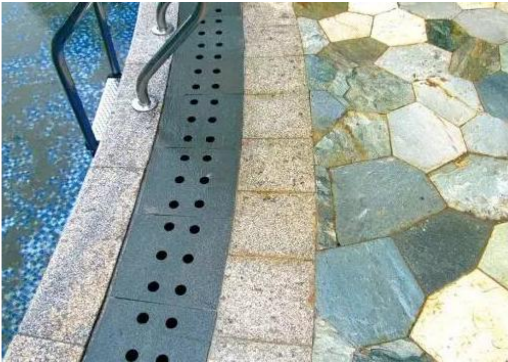
弧形排水沟异形切割、对缝整齐，空隙大小合适，效果较好。
